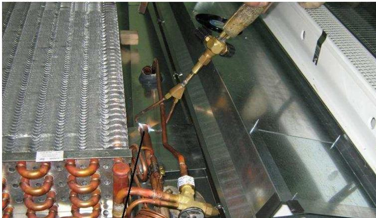
4. После окончания пайки удалить бруски, установить и закрепить испаритель на прежнем месте (фото 4,5).
