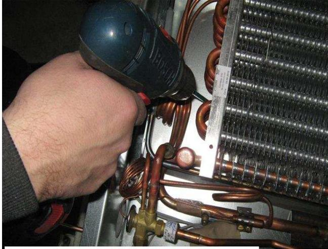
2. Приподнять испаритель за полку трубной решетки на высоту около 40-50мм и завести под испаритель деревянные бруски (фото 2).
